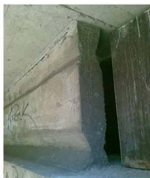
Betonové ložisko
