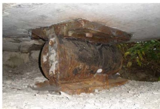
Ocelové ložisko
