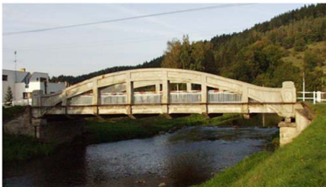
Konstrukce s dolní mostovkou
