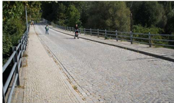
Vozovka s kamennou dlažbou
