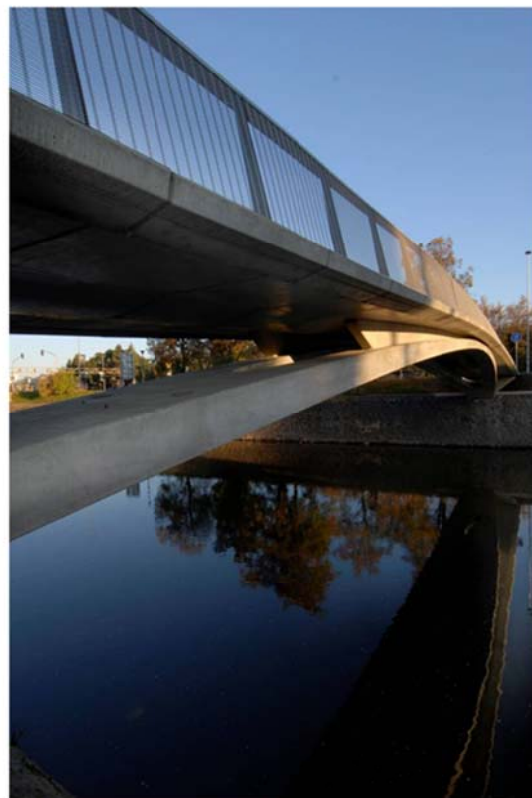
Lávka přes Svratku, Brno, ČR
