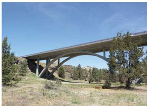
Konstrukce s horní mostovkou
